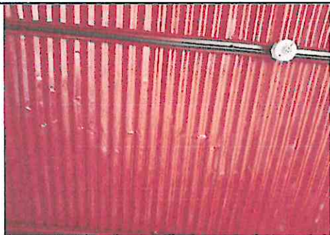
Foto 5: Lámina de la cocina con daños considerables agujeros, cambio de lámina por lámina troquelada.
