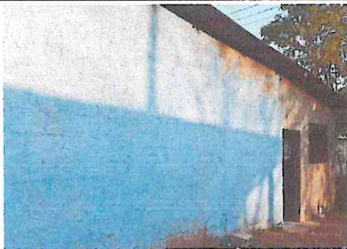
Foto 3: Mantenimiento de pintura parte exterior de pared
