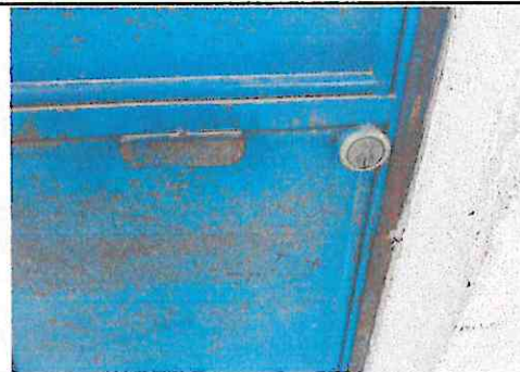
Foto 6: Sustitución de chapa de 2 puertas.
