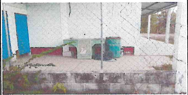
Foto 2: Reparación de tubo hg y malla galvanizada.
